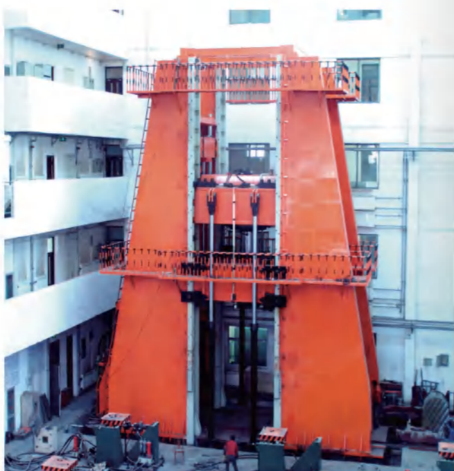
结构试验大厅
